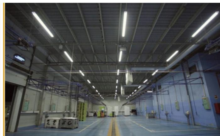
LUMINÁRIA SOBREPOR LINEAR SLIM, 80W MATERIAL EM POLICARBONATO, TENSÃO 110~220V COR DA LUZ BRANCO FRIOS 6500K, ANGULO DE ILUMINAÇÃO 180° GRAUS, LUMINOSIDADE 6400 LUMENS MEDIDAS 240X03X07.
